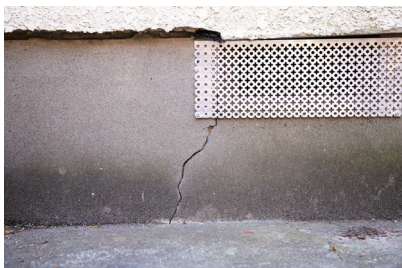
換気口付近の ひび割れ
